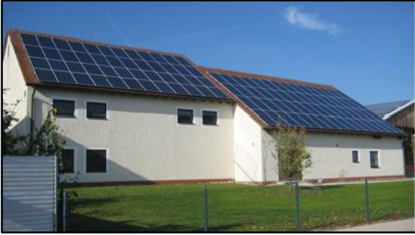
PV auf der Wasserversorgung Beilngries 29,82 kWp
