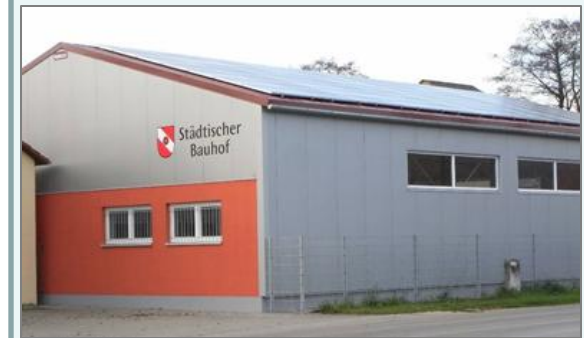
PV auf der Bauhofhalle Dietfurt 38,5 kWp
